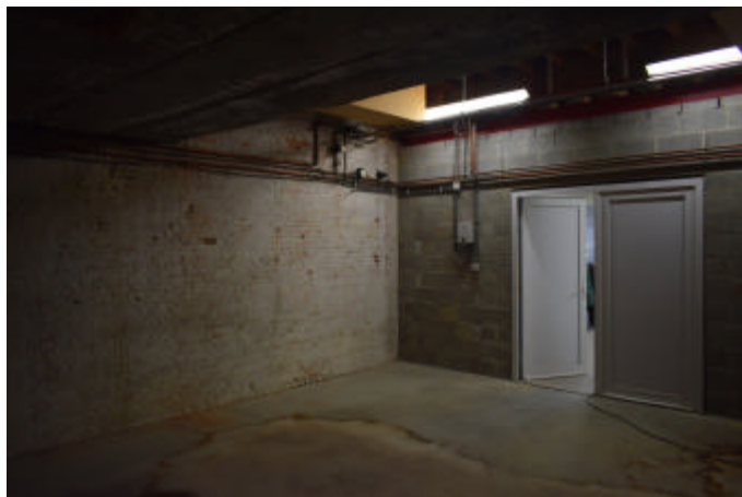
Niet-verwarmde stockageplaats achter magazijn
